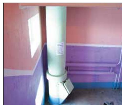
Подъезд, отремонтированный жильцами
